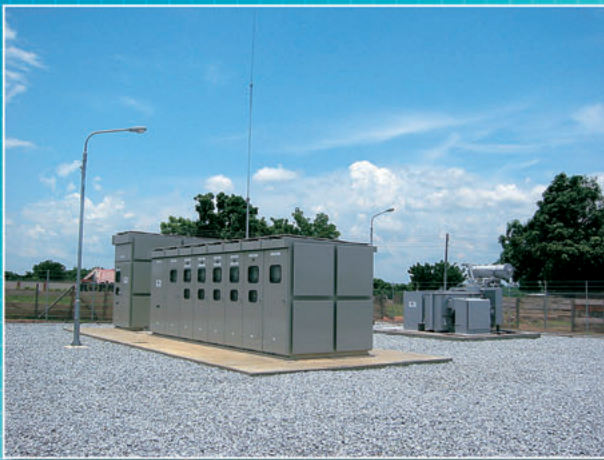
Keana Substation 33/11kV 1000kVA
