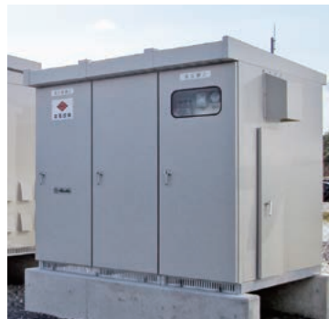
◀受変電盤 Switchgear
