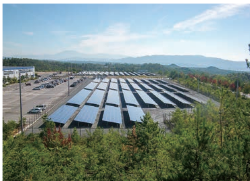
システム容量：2MW
