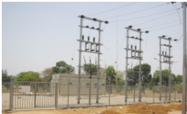
■ オビ開閉所外観
