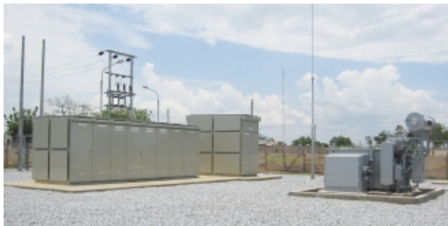
■ ケアナ変電所
