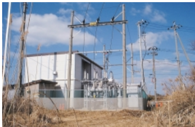
■ 竣工した設備（左側建屋内） （右側既設設備は1年後には撤去される予定）
