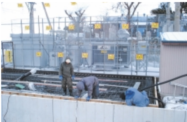
■ 日本海からの吹雪の中で、基礎工事を敢行
