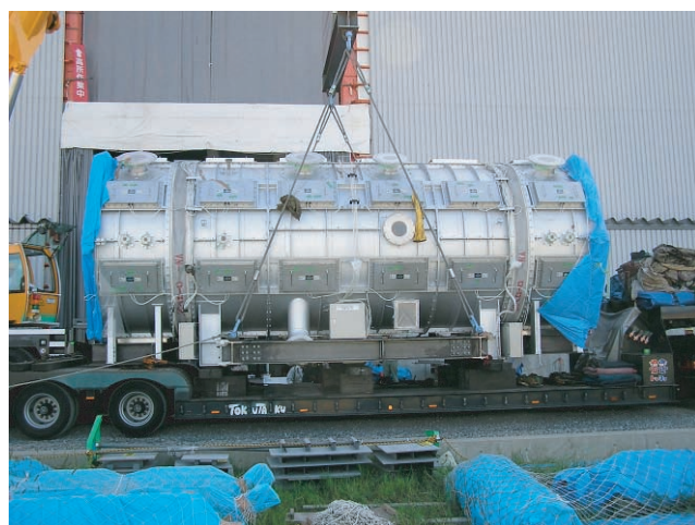
図5 真空加熱炉搬入
