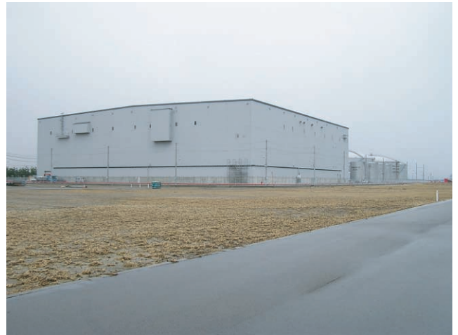
図2 変圧器リサイクル施設全景
