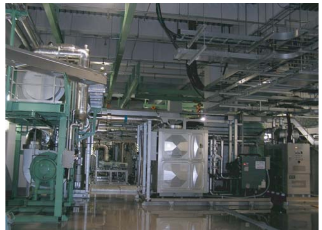
【図3 真空加熱処理設備】
