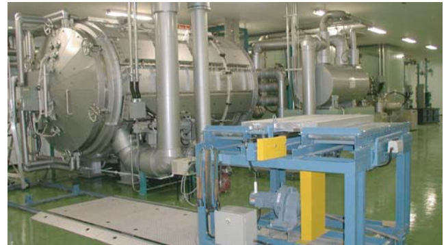
【図1 実証試験設備】
