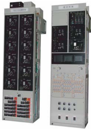
【配電用変電所配電盤(第二世代D配)】
