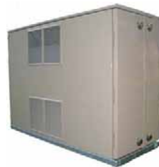
【開閉器付地上設置形変圧器】
