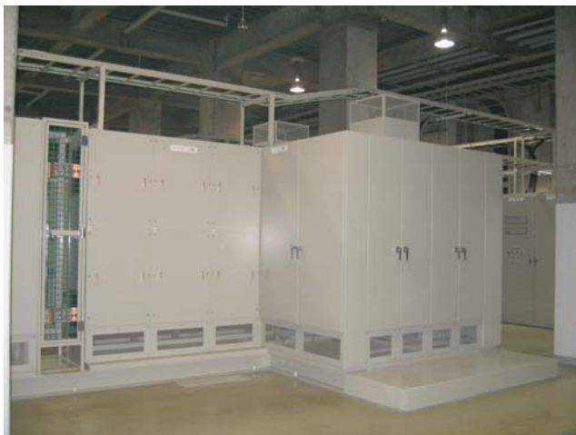
図6 パルス電源外観 (一部)
