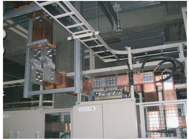
図10 断路器設置状況
