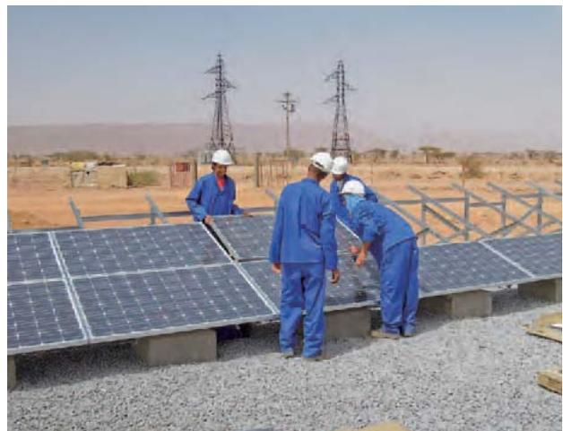
図4 太陽電池モジュール設置作業状況
