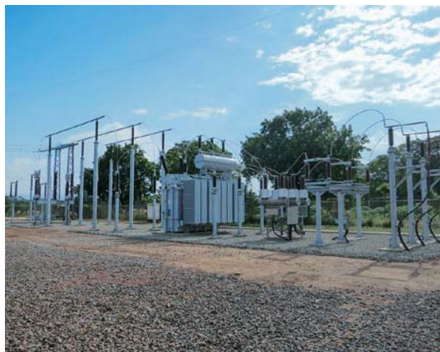
図5 Kiyungi変電所 132/66kVエリア 完成写真
