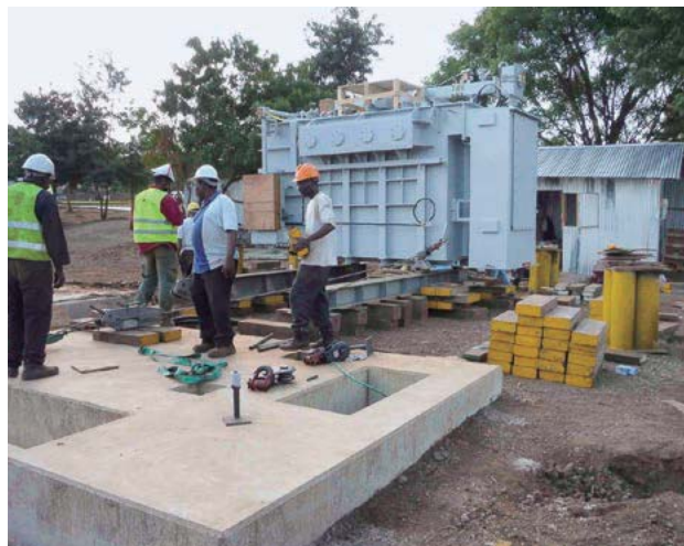
図4 YMCA変電所における変圧器の据付作業
