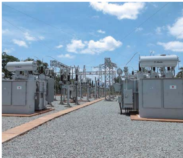
図3 Makuyuni変電所における66/33kV 10MVA 変圧器
