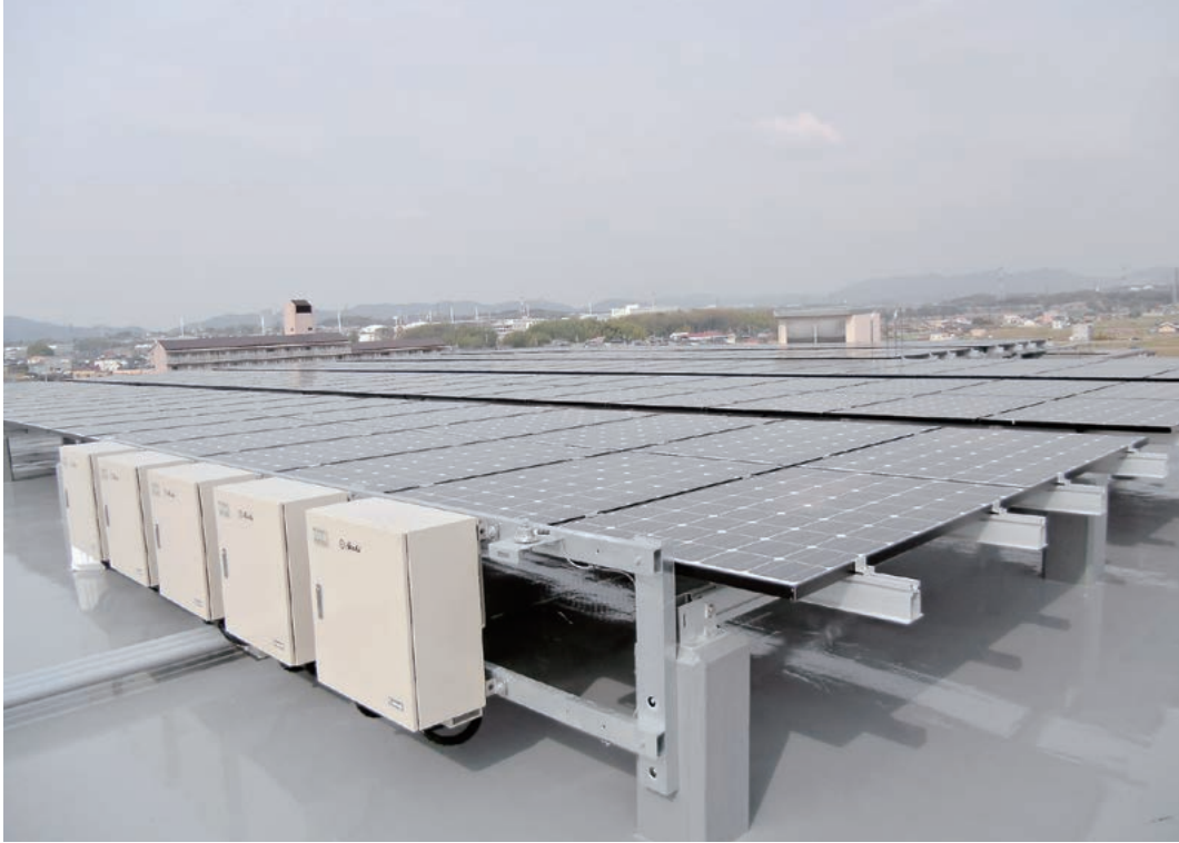
設備設置風景（春日井市総合保健医療センター）
