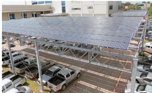
図5 ラオス案件 発電設備外観
