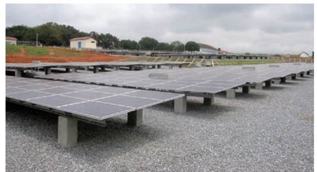
図2 ガーナ案件 発電設備外観
