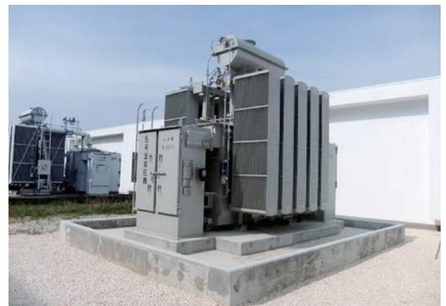
図3 5号機昇圧変圧器 6.6/22kV 19MVA
