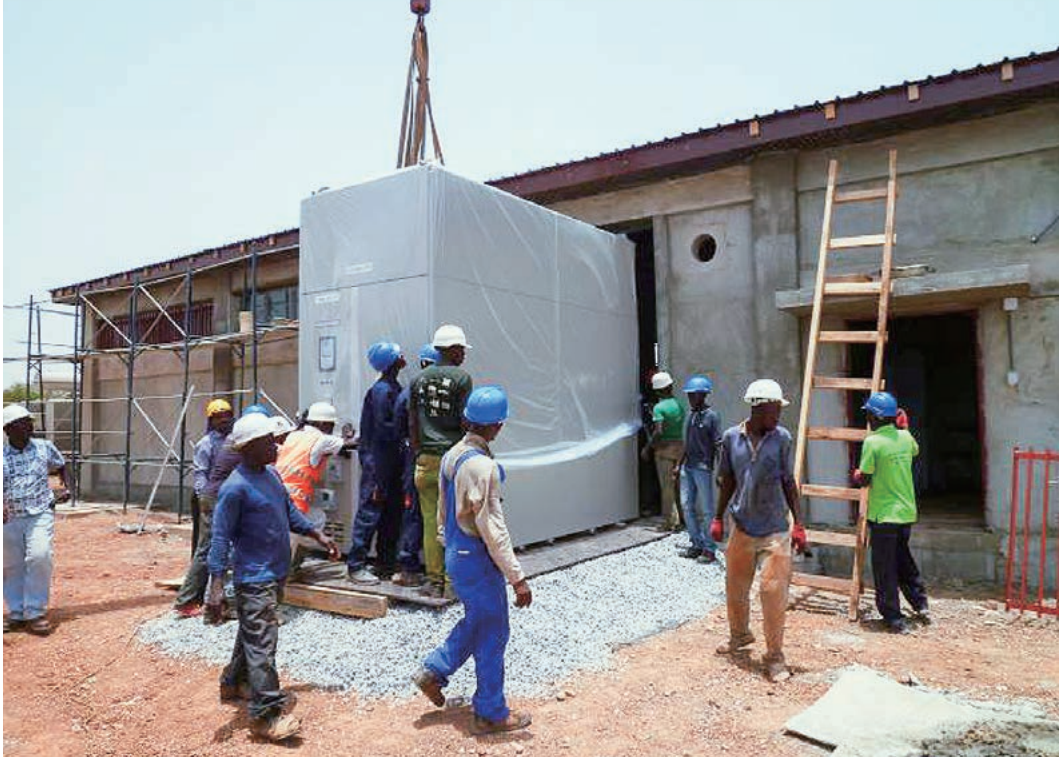
タマレ地区一次変電所の設備設置作業風景
