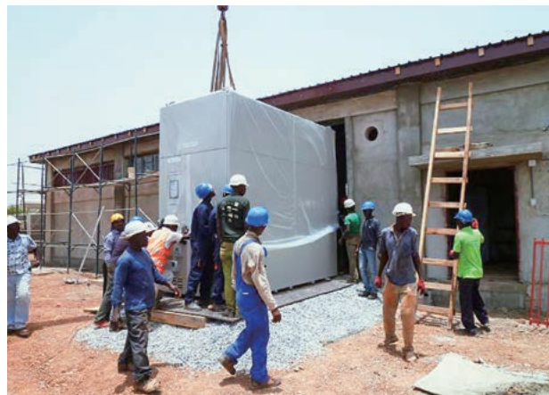
図4 UDS一次変電所における34.5 kV 特高盤の据付作業
