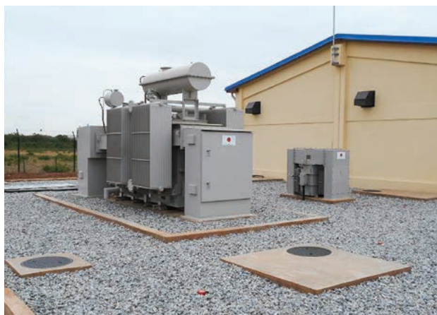
図3 UDS一次変電所 34.5/11.5 kV 7.5 MVA 変圧器
