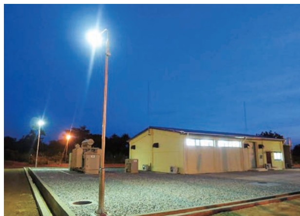
図5 Kotokrom一次変電所 完成写真
