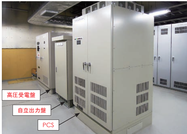
図3 機器設置状況
