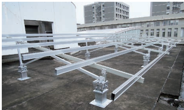
図4 基礎および架台の設置状況
