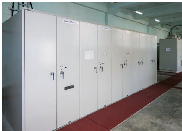
図4 11kV発電機盤の据付状況
