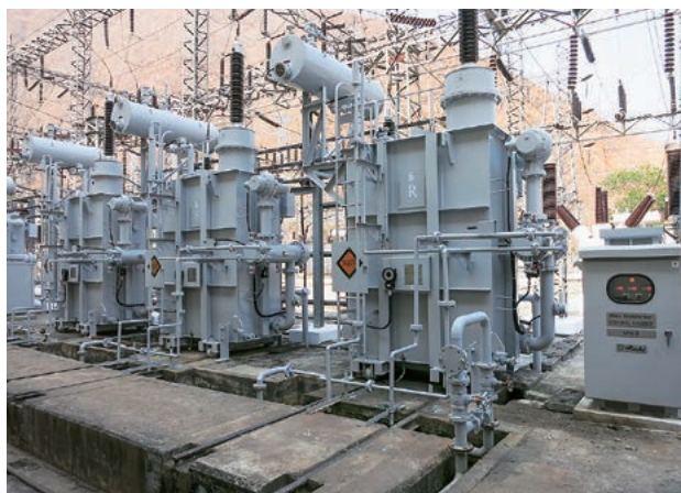
図3 11/132 kV 25 MVA主変圧器
