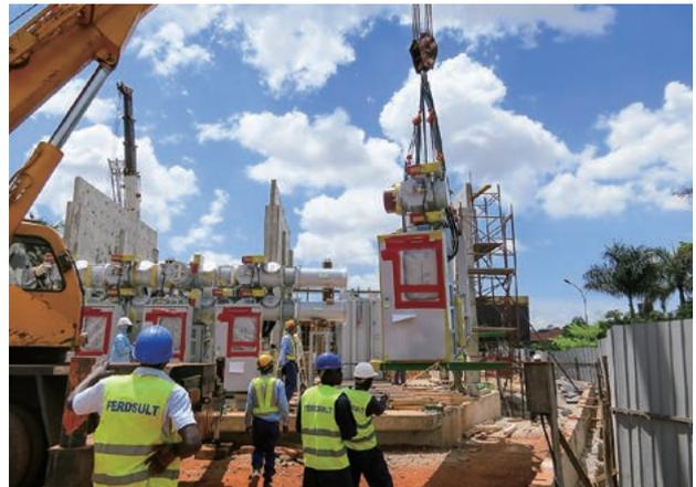
図4 132 kV GISの据付状況
