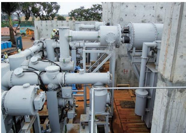
図3 132 kV GISと132/33 kV 40 MVA 主変圧器の直結接続
