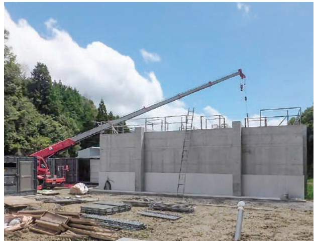
図3 建設中のバイオガス発電プラント
