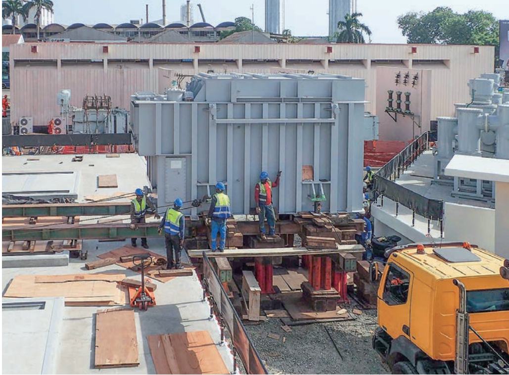
主変圧器の据付作業風景
