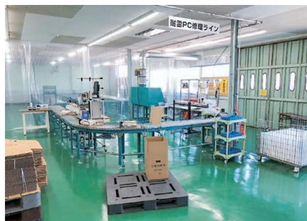
図2 耐雷PC修理ライン外観
