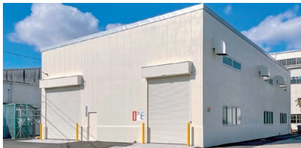
柱上変圧器修理工場の外観
