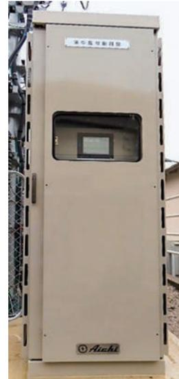
図2 集中監視制御盤の外観
