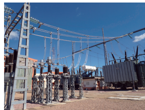
受変電用プラント工事
