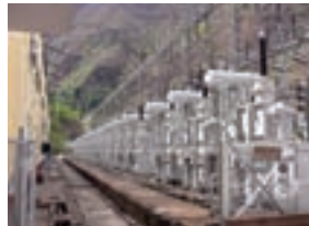
プラント工事
