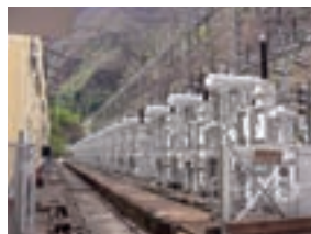
プラント工事
