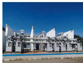
プラント工事
