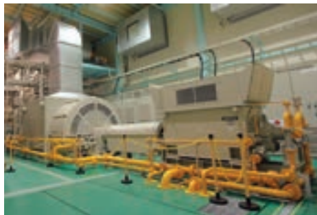
短絡発電機と駆動用誘導電動機
