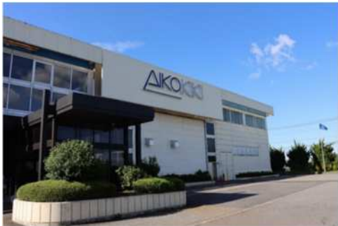
愛工機器製作所 新発田工場
