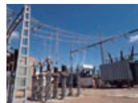
受変電用プラント工事
