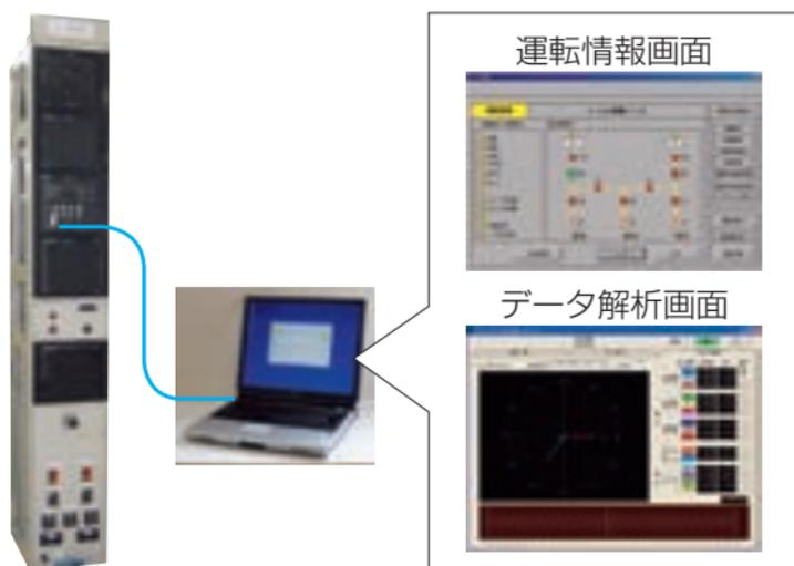
受電自動切替装置（J-PAC：Juden-Power equipment Automatic Controller）は、配電用変電所に設置され、上位送電系統の事故などによって変電所構内が停電になった場合、健全な系統から電力供給を行うことができるよう自動で系統を切り替える装置です。今回、新型のJ-PACを開発し、中部電力㈱に納入を開始しました。
