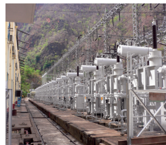
プラント工事
