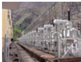
プラント工事
