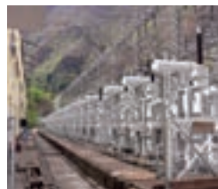
プラント工事
