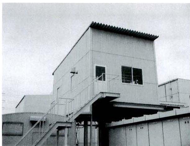
図6 / 負荷設備の全景
