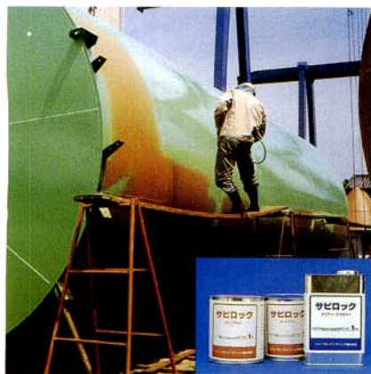
防錆工事(サビロック工法)
