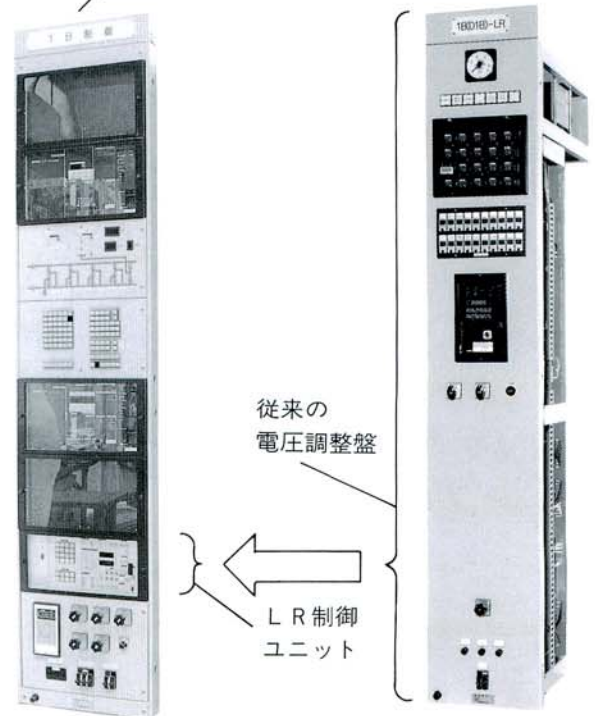
LR制御ユニット を収納した配電盤
