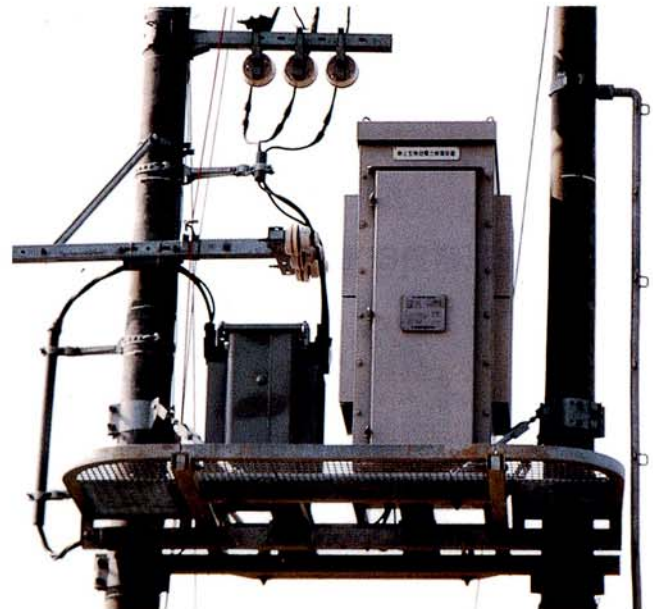
降圧変圧器 電圧調整器部
