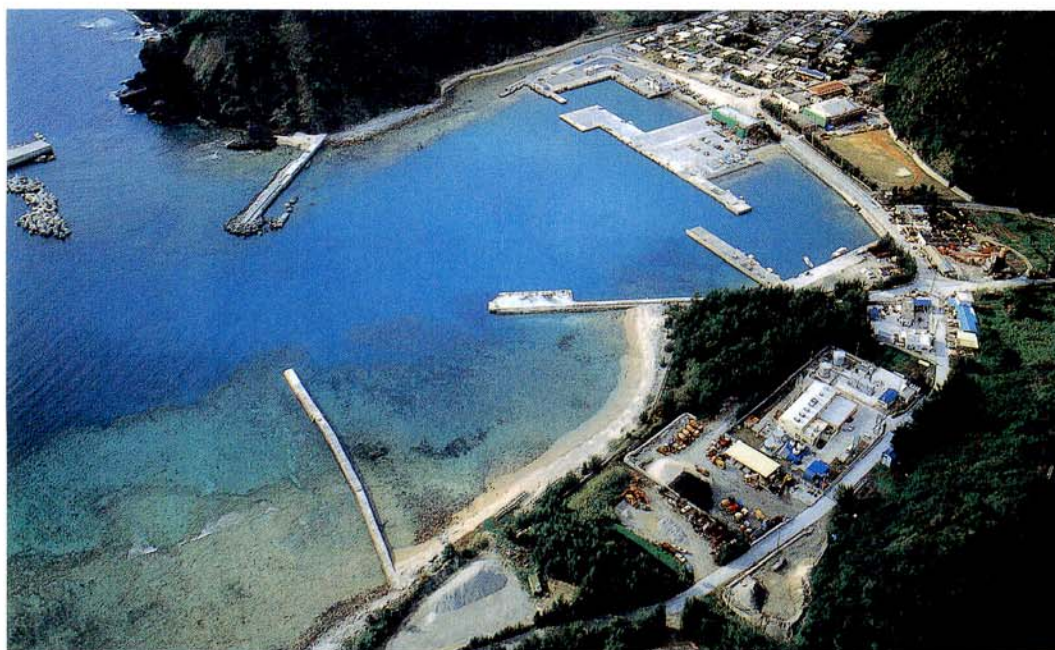
渡嘉敷港と渡嘉敷発電所 (右下)
