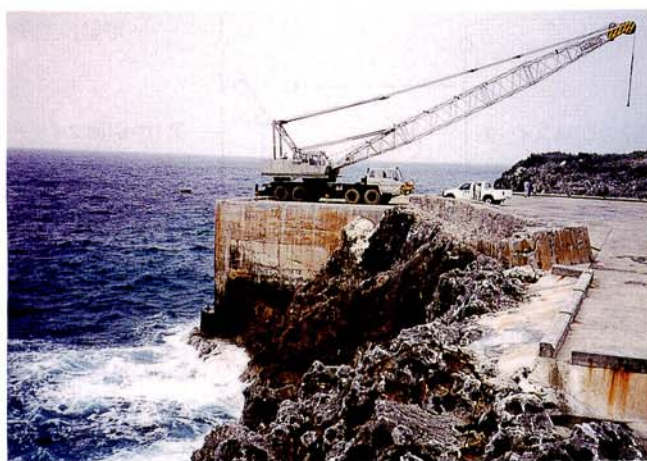
北大東発電所 揚陸岸壁
