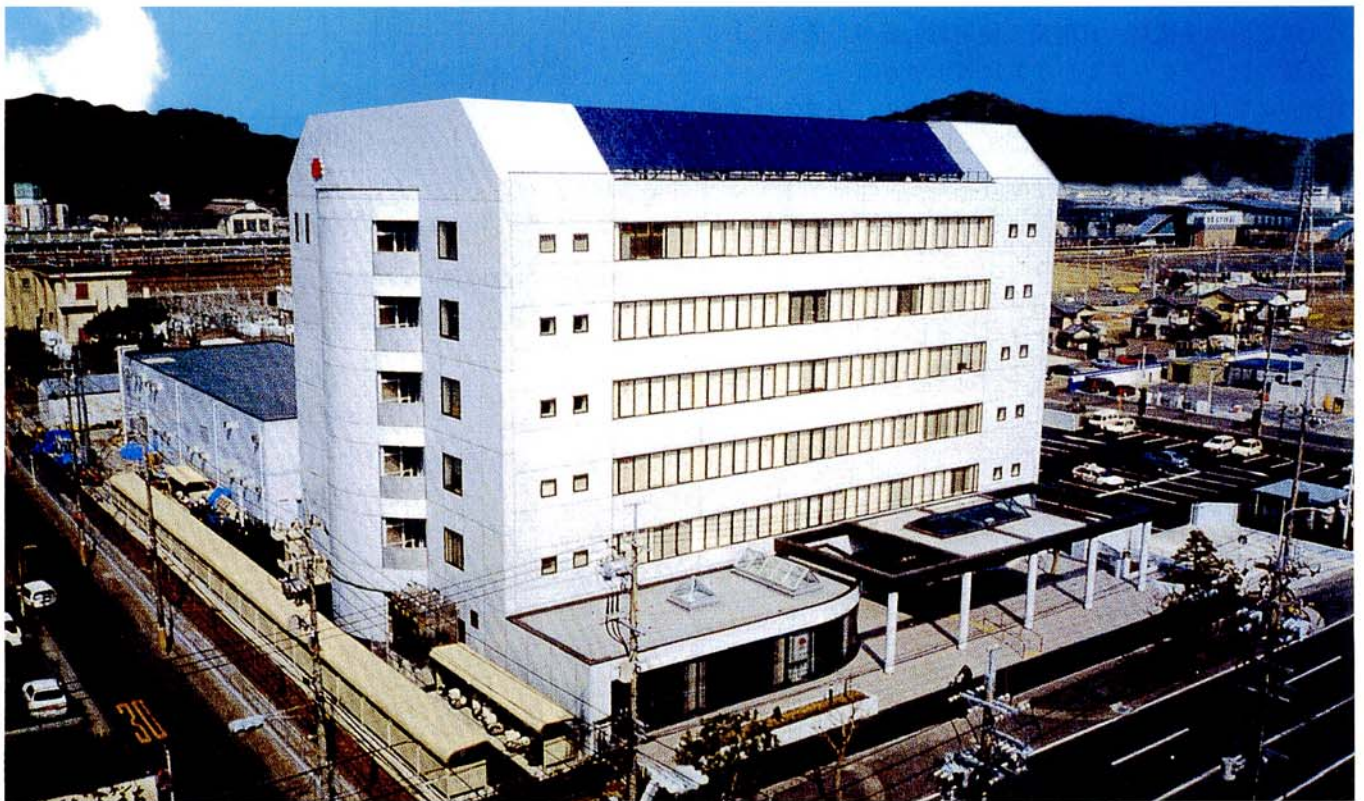
■ 静岡営業所殿・太陽光発電システム設置状況
