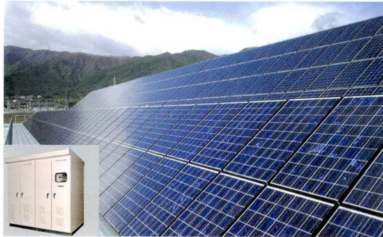
セイコーエプソン(株)伊那事業所殿納め50kW太陽光発電装置 (本誌22号新製品紹介の10kWユニットインバータ×5台を使用)
