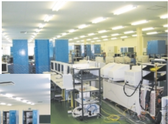
試験中の配電線自動化親局
