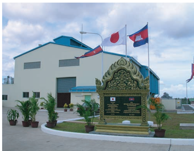
■ モニュメントと発電所本館
