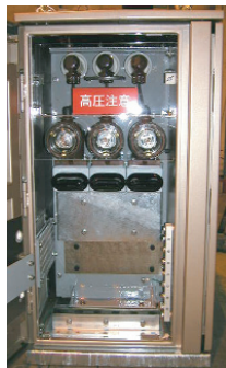
内部構造(高圧側)
