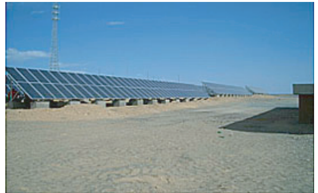
■ 太陽光発電ユニット (100kW:165W×630枚)
