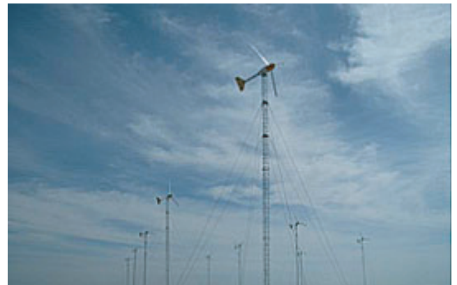
■ 風力発電ユニット (100kW:10kW×10基)
