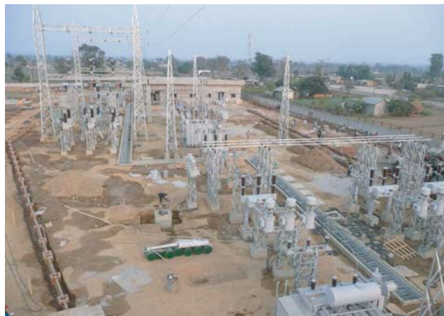
図5 建設中の変電所
