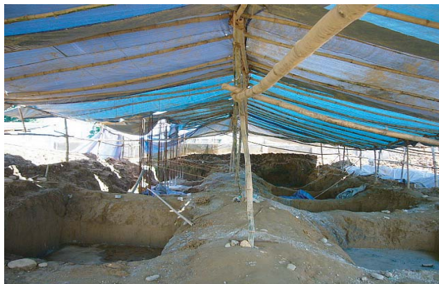
図4 雨季が始まり仮屋根で覆っての基礎工事
