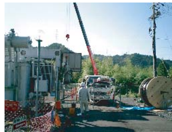
6.6kV電力ケーブル取替
