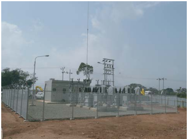
図2 Ⅱ期工事(キャパシター・ステーション)
