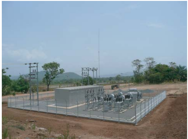
図1 Ⅰ期工事(ブースター・ステーション)
