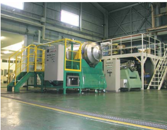
図4 試験エリア (旧作業エリア)
