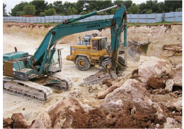
図6 削岩機による掘削作業
