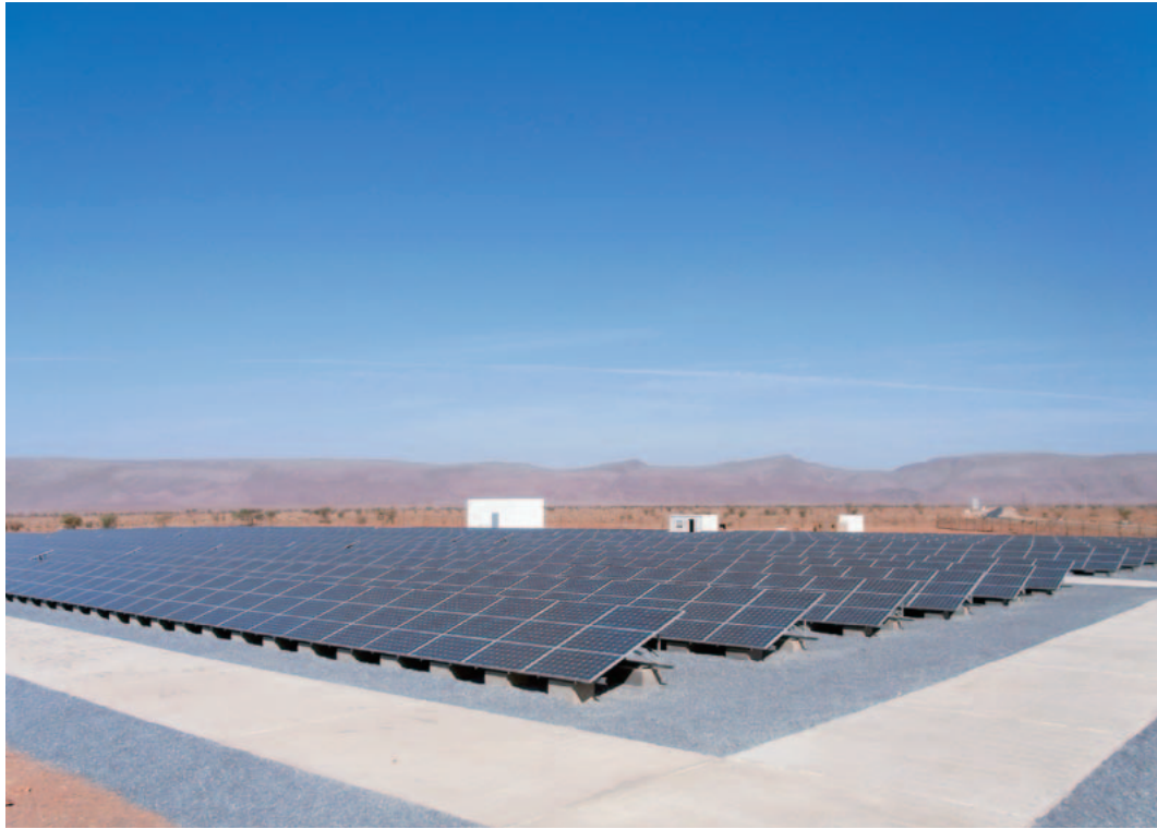
モロッコ王国における太陽光発電所全景（建設中）
